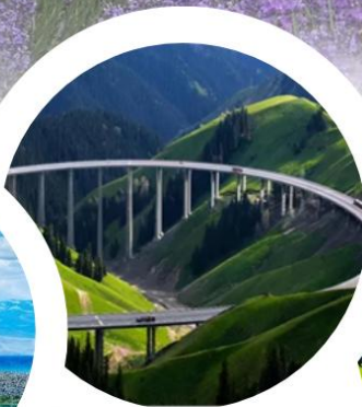
สะพานกัวจื่อโก
